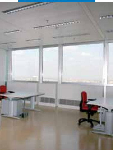
Posa di pavimento resiliente effettuata su supporto liscio con Pianocem Medio miscelato con acqua e Livigum. Grattacielo Pirelli - Milano - Italia
